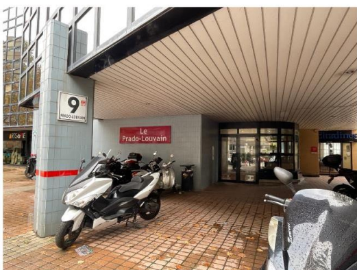
*Entrée du bâtiment
